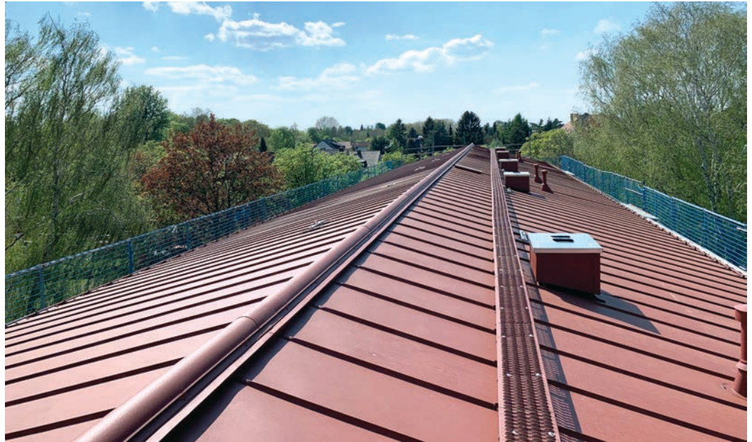
Neue Dacheindeckung Rosentreterpromenade, Foto: Hoeltke
