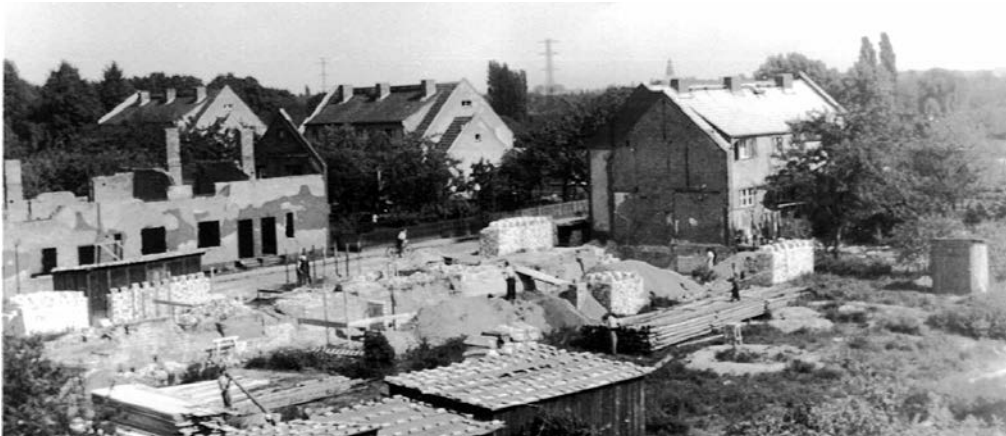
Aufnahme vom Mai 1953, links Brandschaden Steilpfad 67/75
