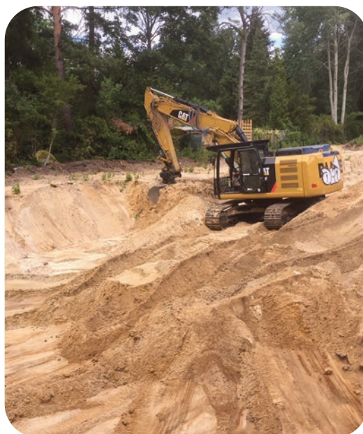
Ausheben der Baugrube
