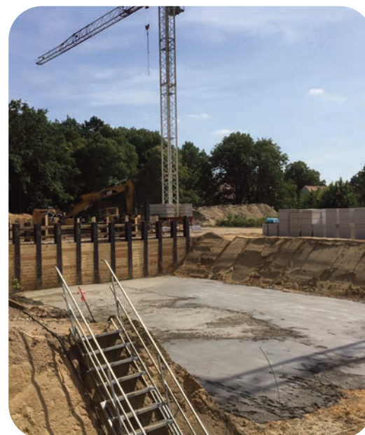
Herstellung der Sauberkeitsschicht
