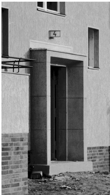
Historische Eingangssituation im Talsandweg; Aufnahme 1937 (Archiv)
