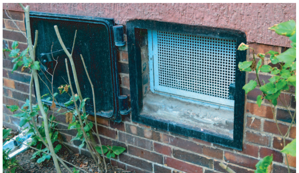
Kellerfenster mit Splitterschutz am Haus Talsandweg 15 (Liepold)
