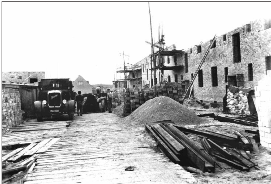
Bauarbeiten 1937 im Talsandweg Blick zum Waidmannsluster Damm (Archiv)
