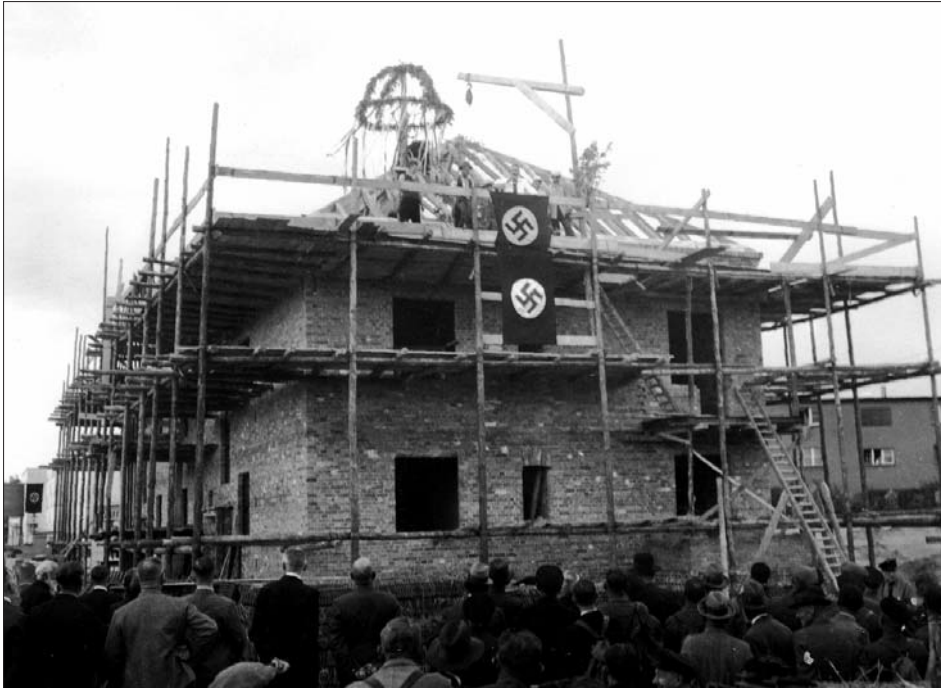
Richtkranz auf dem Baublock Waidmannsluster Damm 64/64A (Archiv)
