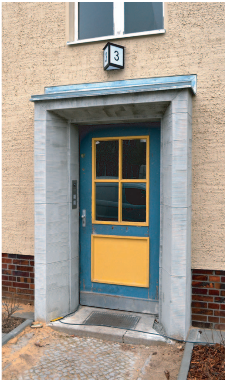
Block Talsandweg 3/9, neugestalteter Eingangsbereich; Aufnahme Januar 2016 (Liepold)
