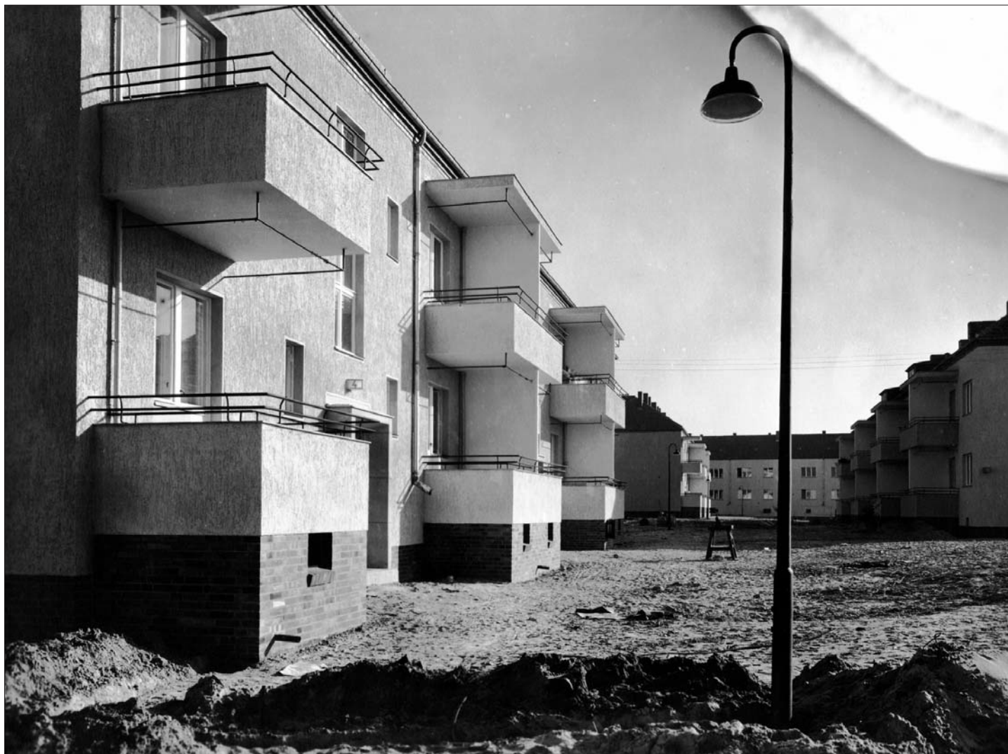
Talsandweg 4/22 nach der Gebrauchsabnahme 1937 (Archiv)
