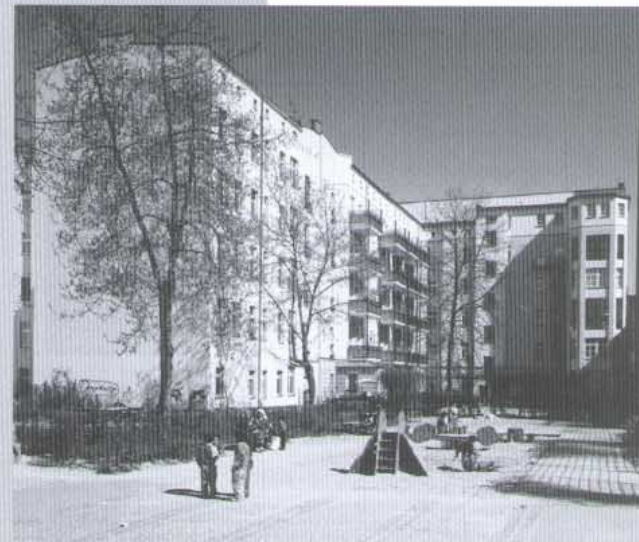
Sanierter Wohnhof Oudenarder Straße
