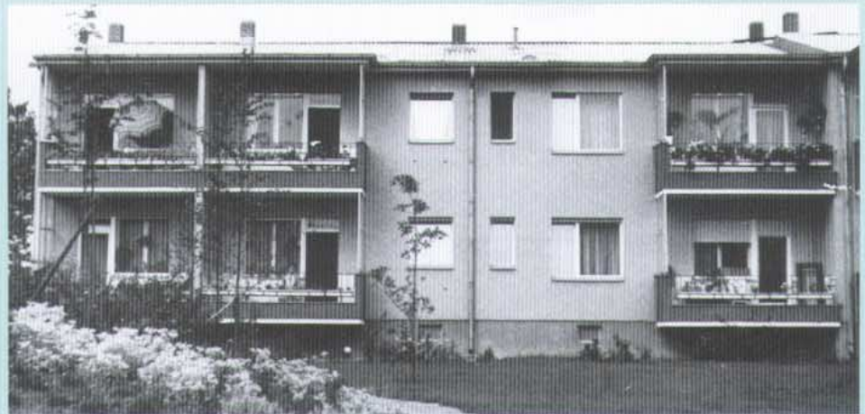
Ansicht Gartenseite Zabel-Krüger-Damm 84
