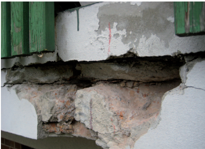
So sahen die alten Balkone aus.
