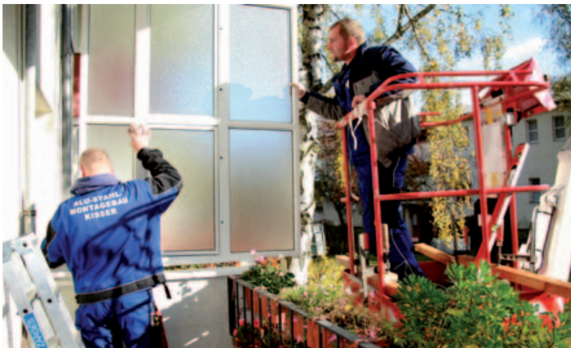
Die Montagearbeiten auf den Balkonen waren ohne größere Einschränkungen schnell erledigt.
