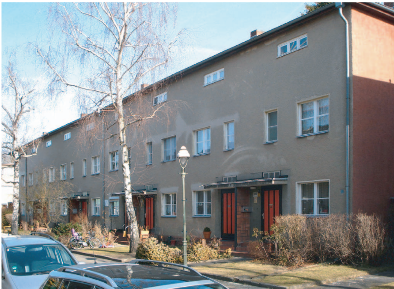
Allmendeweg 106/122 vor der Sanierung
