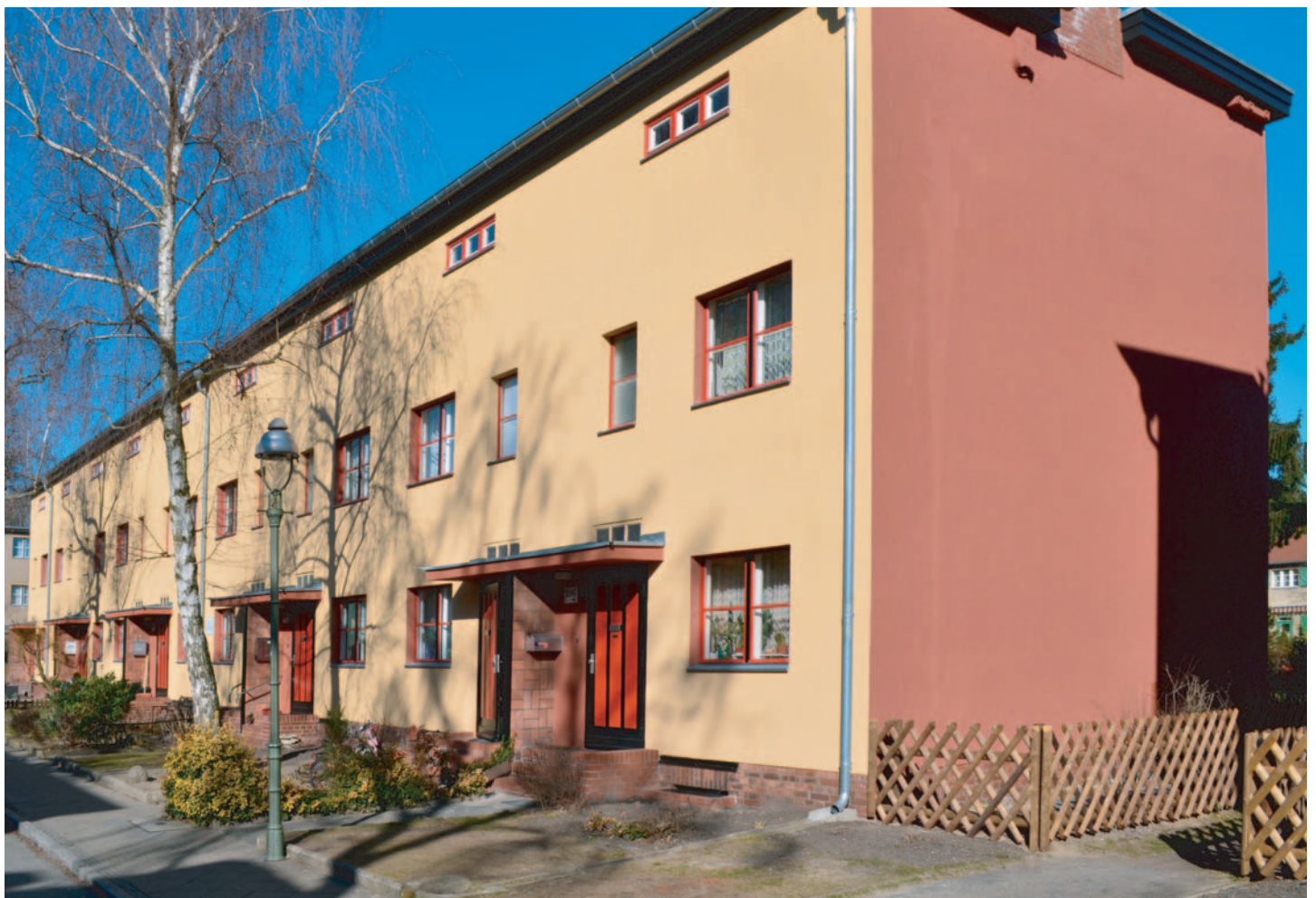
Allmendeweg 106/122 nach der Sanierung
