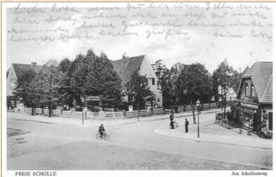
Ansichtskarte ca. 1928 (gelaufen 14.9.1929) Deutlich ist der Wegfall der Vorgartenbereiche entlang des Waidmannsluster Damms zu sehen.
