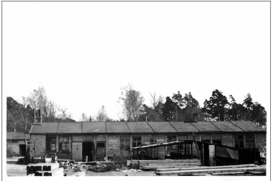
Baracken und Lagerplatz am Waidmannsluster Damm 81; Aufnahme April 1951 (Archiv)
