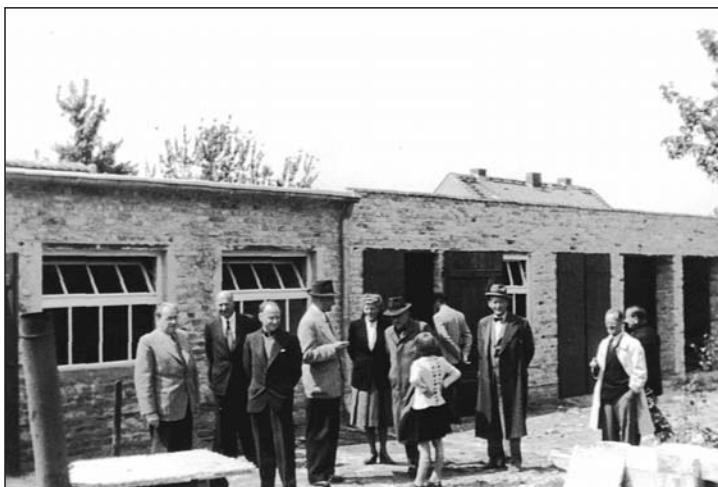
Besichtigung des Rohbaus durch Vorstand und Aufsichtsrat im Mai 1952 (Archiv)
