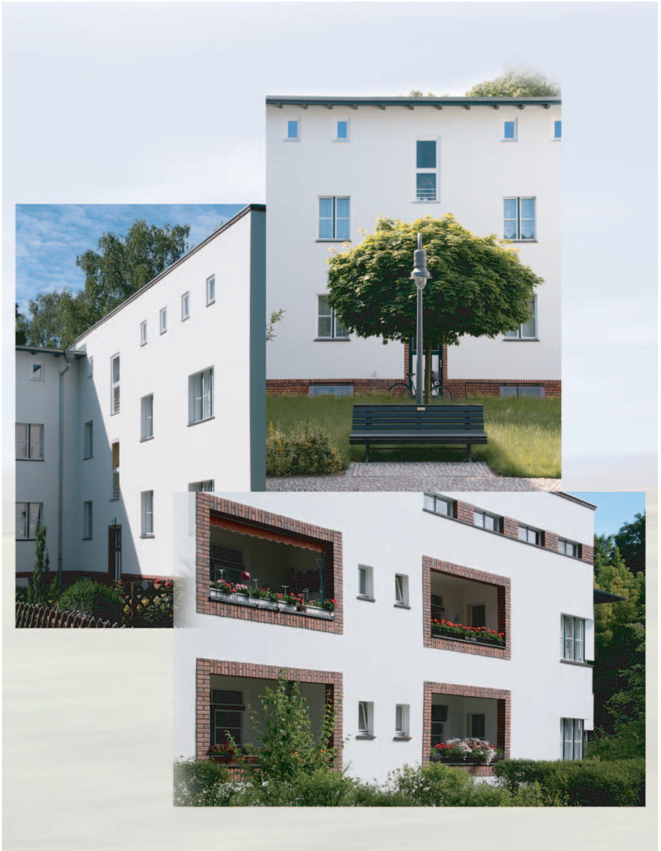
Denkmalgerechte Fassadensanierung im Erholungsweg 8/10/12 in Berlin-Tegel
